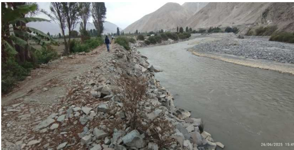
FIGURA N°03: TRAMO 03 PUNTO FINAL DE TRAMO CRITICO n° 03 Y PUNTO FINAL DE ACTIVIDADES TALUD DE DIQUE NO CUENTA CON ENROCADO DE PROTECCION, HACE UN AÑOS SUFRIÓ SOCAVACION Y EROSION DE TALUD
