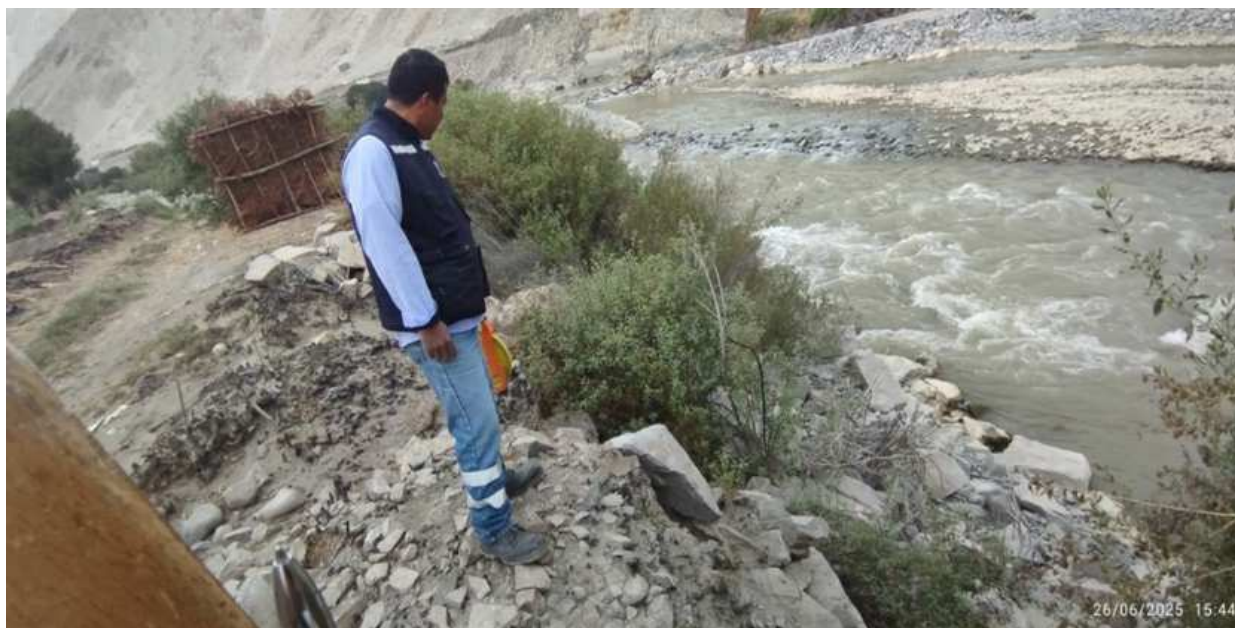
FIGURA N°02: TRAMO CRITICO 02, , PERDIDA DE PROTECCION DE ENROCADO EN TALUD DE DIQUE.
