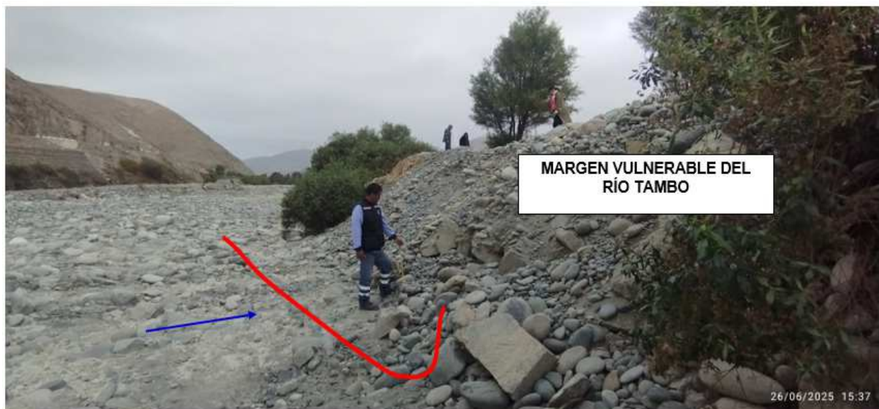
FIGURA N°01: TRAMO 01 INICIO DE ACTIVIDADES, TALUD DE DIQUE SIN ROCA DE PROTECCION
